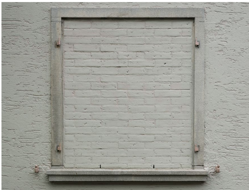
oben: Aussichts-Lukarne von Aussen / unten: Schliessung einer alten Fensteröffnung
