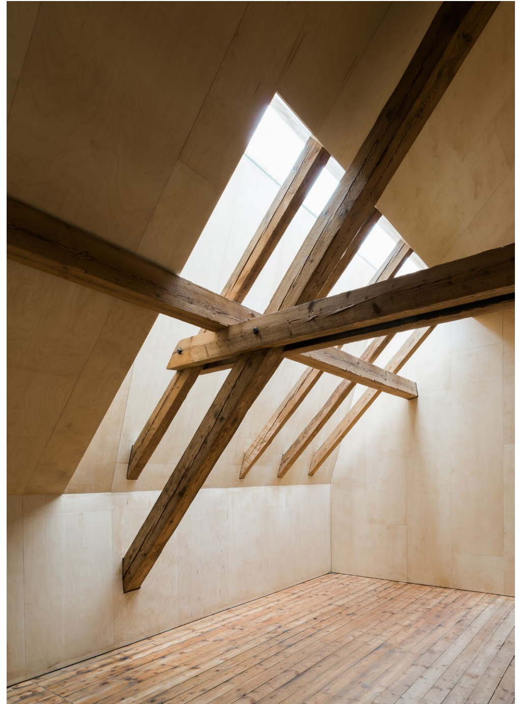
Zenitallicht-Lukarne, neue Sperrholzoberflächen und altes Gebälk
