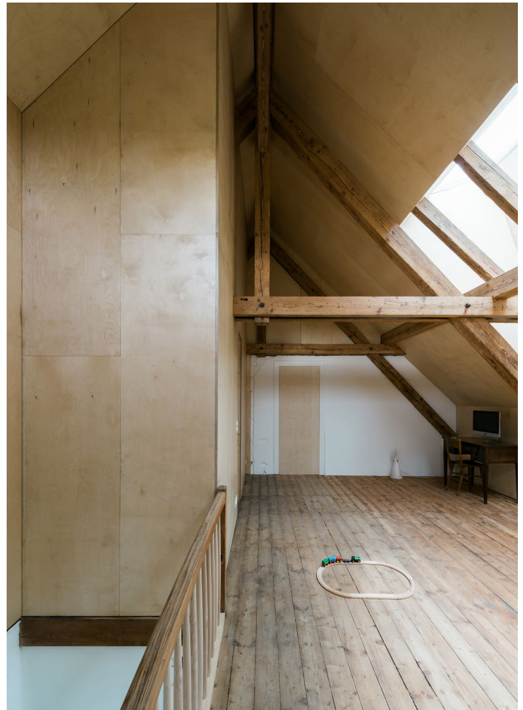
Durch das Entfernen des Estrichs entstand ein spannender, überhoher Dachraum als Abschluss der Raumsequenz
