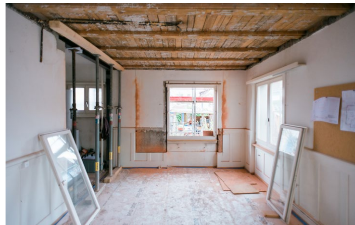
Baustellenfotos, die präzisen Abbrüche als erster Schritt der Erneuerung
