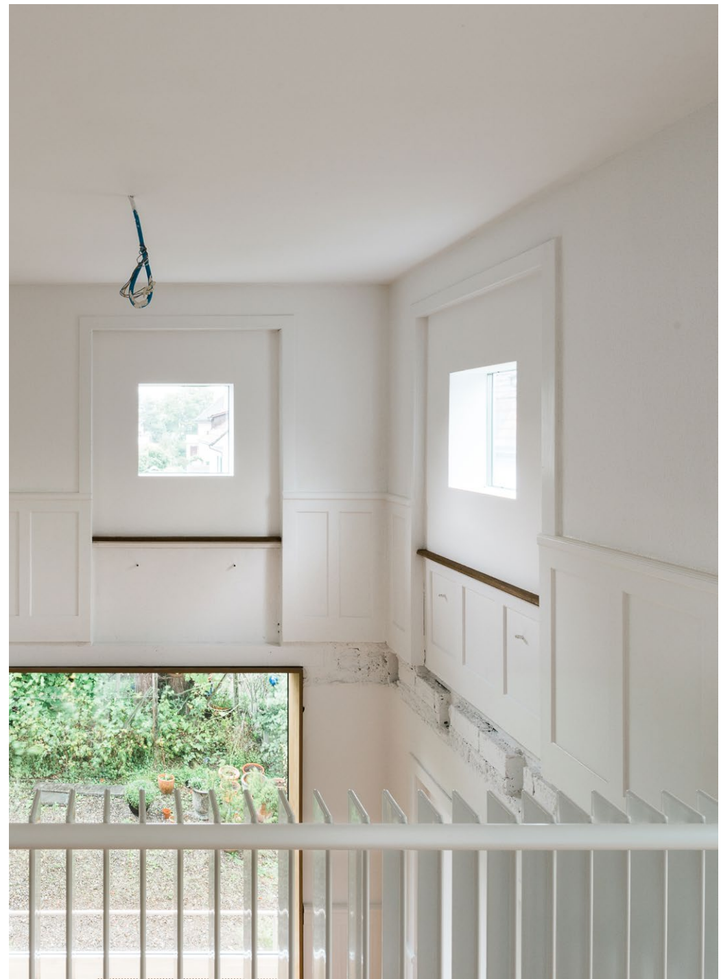
Blick von der Galerie, Heizkörper als semitransparente Brüstung
