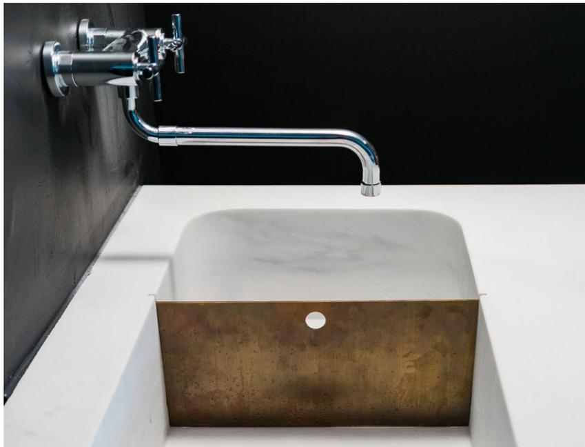
oben: Messing-Griffleiste Tür zu den Nasszellen / unten: Messing-Trennwand im Waschbecken
